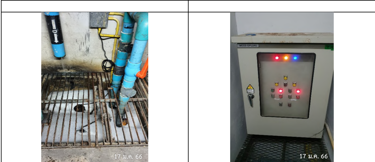
รูปที่ 2-11 ปัมป์สูบน้ำภายในโครงการ
